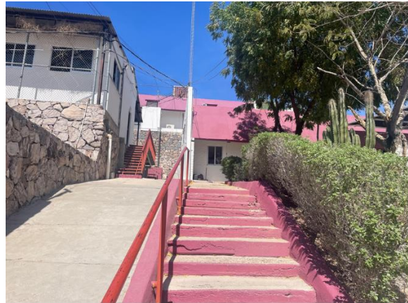
Acceso entre distintos niveles de edificios
